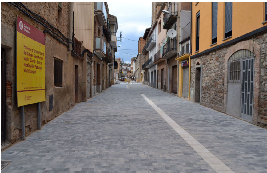
Imatge recent de les obres de reurbanització al carrer Sant Antoni Maria Claret L'actuació va ser inclosa en la darrera convocatòria del Pla Xarxa de la Diputació
