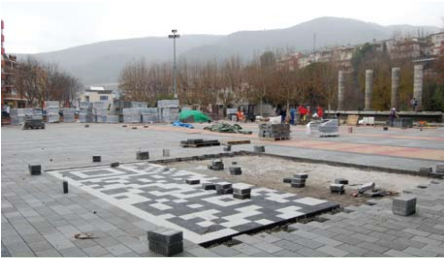
Les obres del Pla de la Font, en la primera quinzena de desembre Les dues actuacions, iniciades l'estiu passat, es troben en la darrera fase
